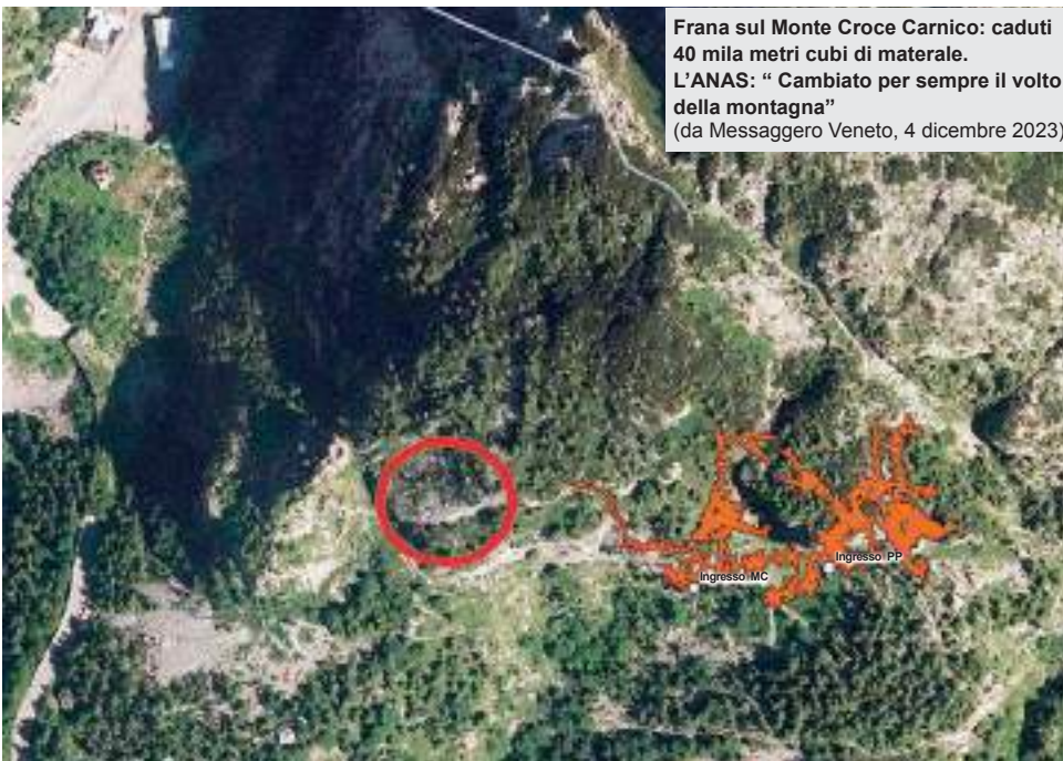
Fig. 15 - Andamento planimetrico del Complesso del Monte Croce rispetto alla parete franata (cerchio rosso).
